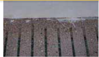
Repareer ruwe betonroosters en vloeren en breng een coating aan.
